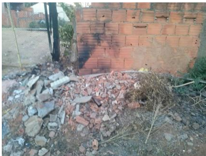
Figura 1: Acúmulo de lixo na avenida Quincas Souto. Autor: OLIVEIRA, 2015
